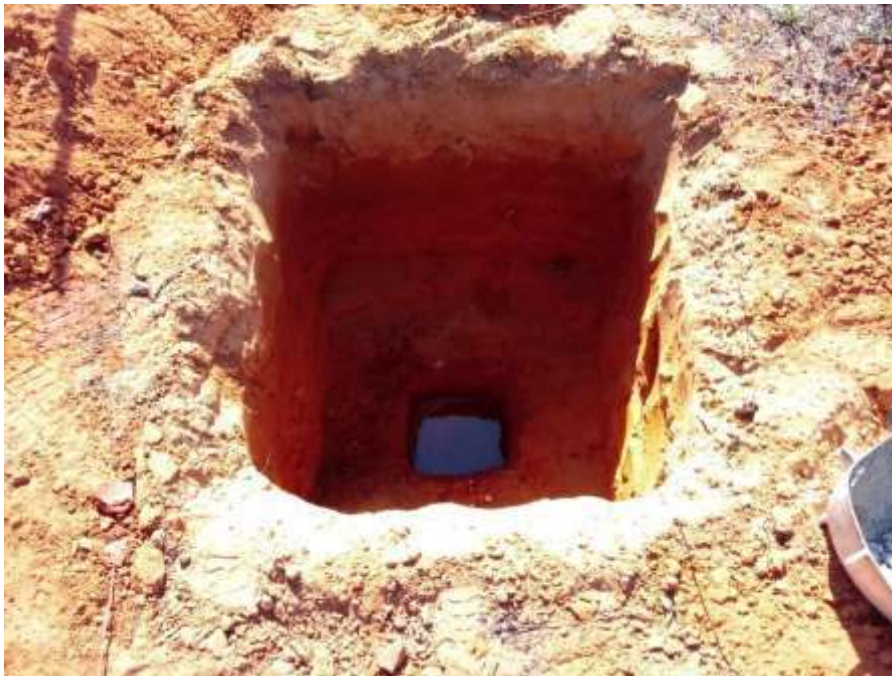
FOTO 3 – FASE DE COLOCAÇÃO DA ÁGUA
