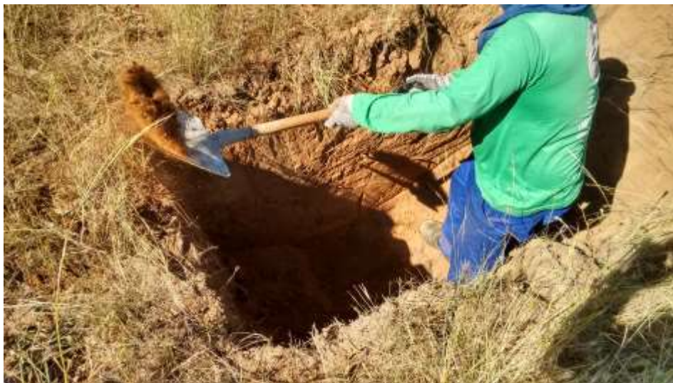
FOTO 2 – FASE DE REGULARIZAÇÃO DA VALA MAIOR
