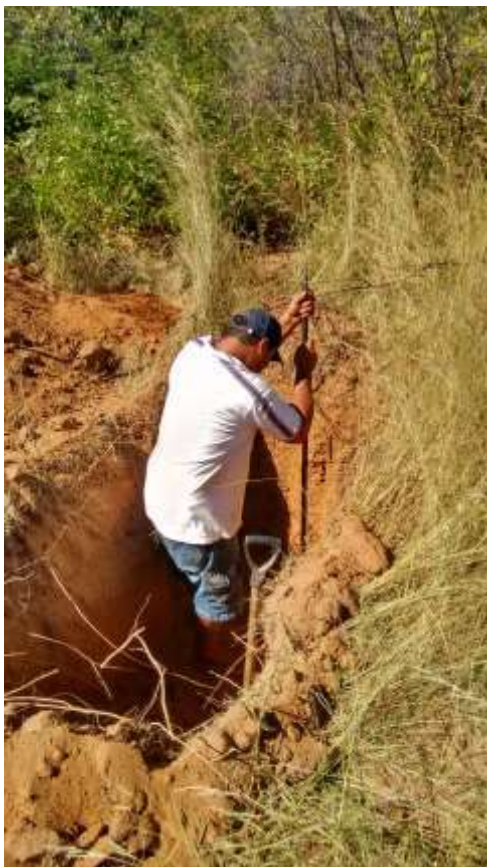
FOTO 1 – FASE DE ESCAVAÇÃO DA VALA MENOR
